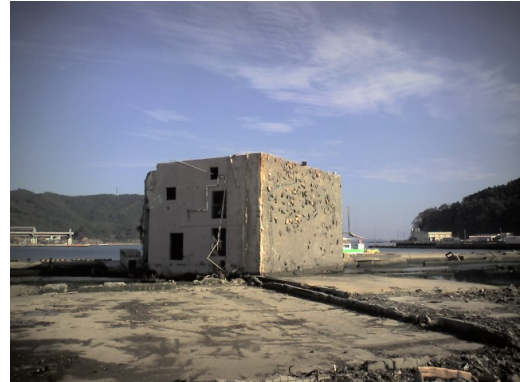
図-4.14 東日本大震災時に宮城県女川町女川浜海岸傍で転倒していた鉄筋コンクリート製ビルディング (建物本体が地盤に固定されていなかったため、津波力によって転倒していた稀少事例)
